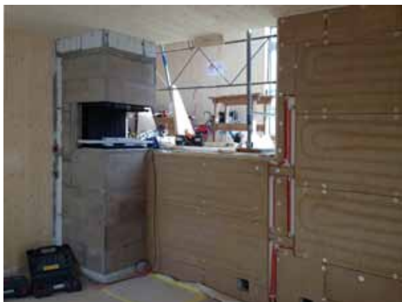
In der mit Lehmbauplatten beplankten Innenwand liegen die Wandheizungselemente. Darauf wurde ein Lehmstrukturputz aufgetragen
