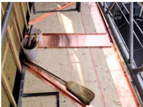
Einer der auskragende Erker von oben: Die Dächer erhielten eine hochwertige Kupfer-Stehfalzdeckung
